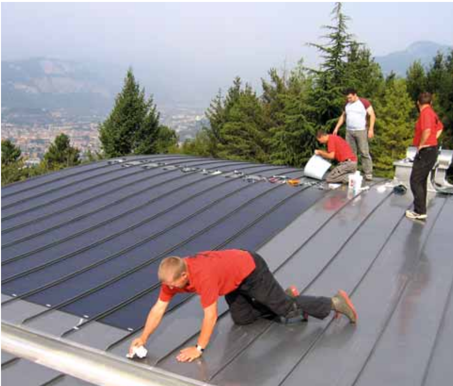
Die flexiblen Photovoltaiklamine passen sich der Form des Aluminiumdaches an und finden exakt zwischen den Stehfalzen Platz.
