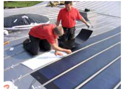
Wichtig für den guten Halt der selbstklebenden Lamine ist eine gründliche Reinigung des Untergrundes vor dem Aufbringen.
