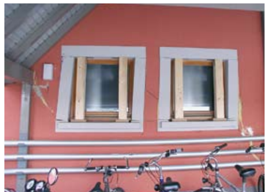
Risse statt Erdwärme: Inzwischen sind über 200 Gebäude in der historischen Altstadt von Staufen beschädigt. Fotos: Stadt Staufen
