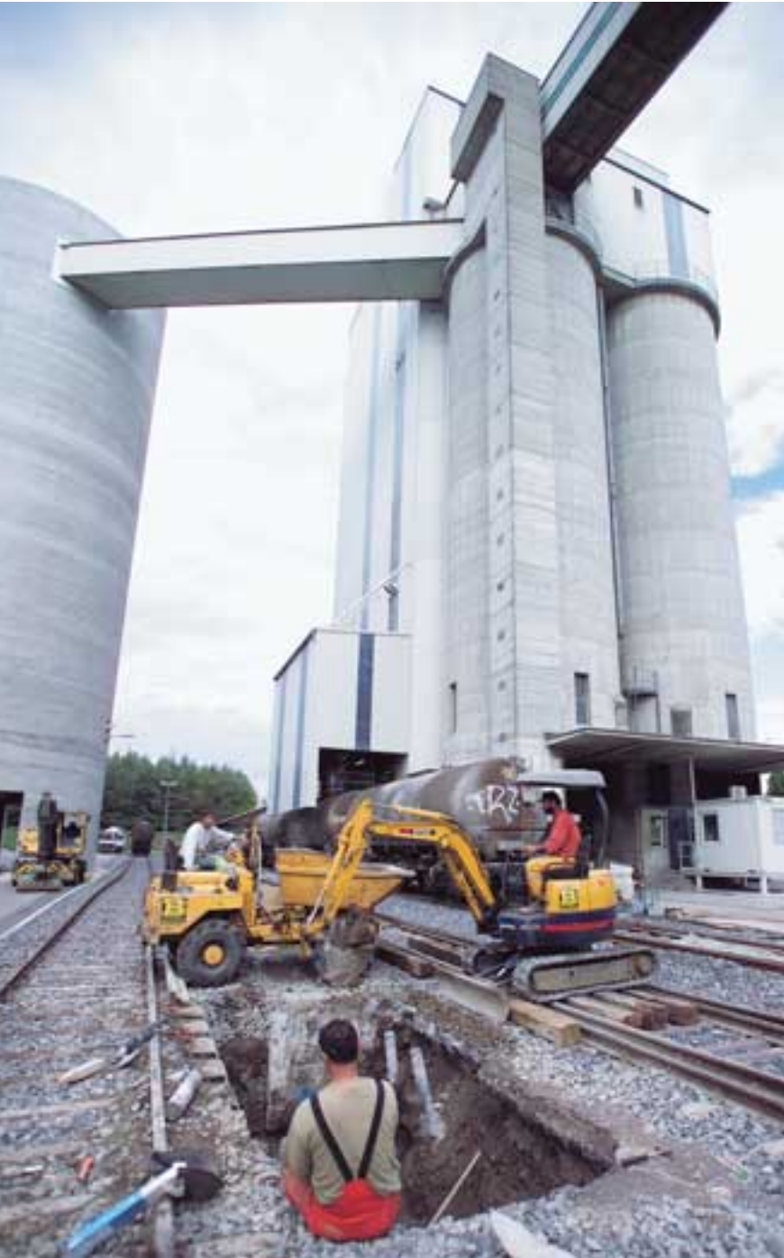
Im Zementwerk Siggenthal: Für das neue Bahnsilo müssen die Gleisanlagen erweitert werden.
