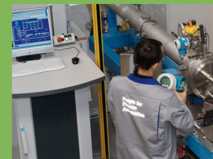
Garantierte Genauigkeit: Endress+Hauser Techniker Thierry Stoque an der Kalibrieranlage in Huningue.
