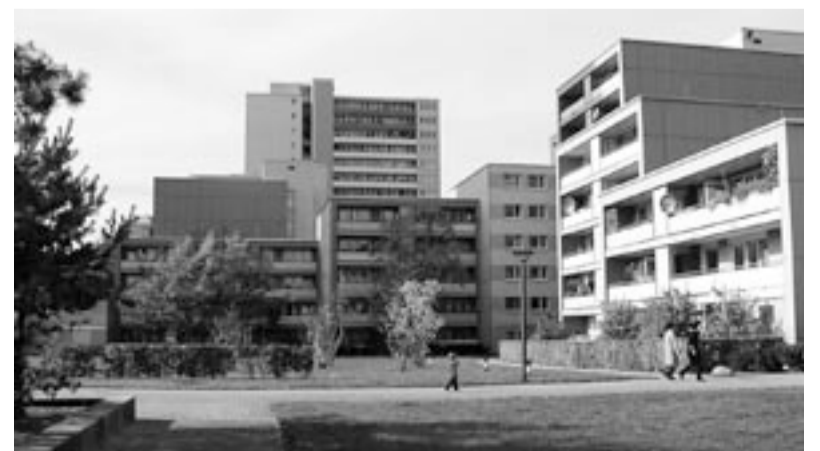
Teure Reparatur: Der Freiburger Stadtteil Weingarten, der in den 70er-Jahren für 12.000 Bewohner errichtet wurde, hat schon ein Vielfaches der ursprünglichen Baukosten verschlungen. Foto: Stadtplanungsamt Freiburg
